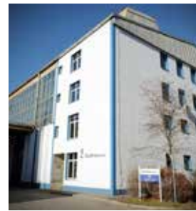
Ravne na Koroškem, Slowenien
