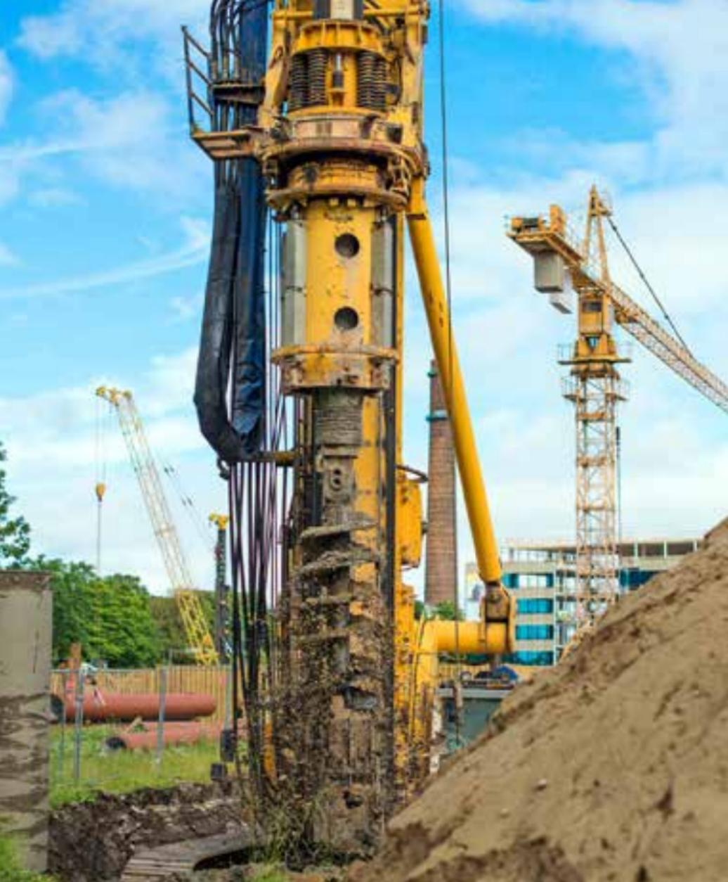
Das Kellybohrverfahren ist das am weitesten verbreitete Großlochbohrverfahren in der Tiefbohrtechnik. Mit Stahlprofilen von ZOLLERN werden Drehmomente bis 500 kNm problemlos übertragen. An dem mehrfach teleskopierbaren Bohrgestänge, der sogenannten Kellystange, sind die Stahlprofile als Führungs- und Mitnehmerleisten angebracht. Bohrdurchmesser bis 3 Meter und Bohrtiefen bis 90 Meter werden dabei realisiert.
